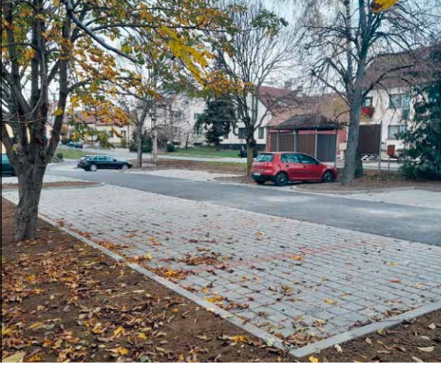
Komunikace Dolní Němčí
